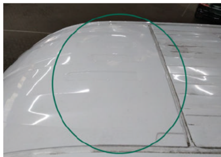
Dach / Vorne / Delle
