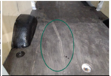
Holzboden / Hinten / Kratzer
