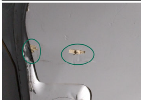
Innenverkleidung Laderaum / Rechts / Gebrochen
