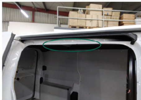
Dichtung Türeinstieg / Rechts / Fehlt
