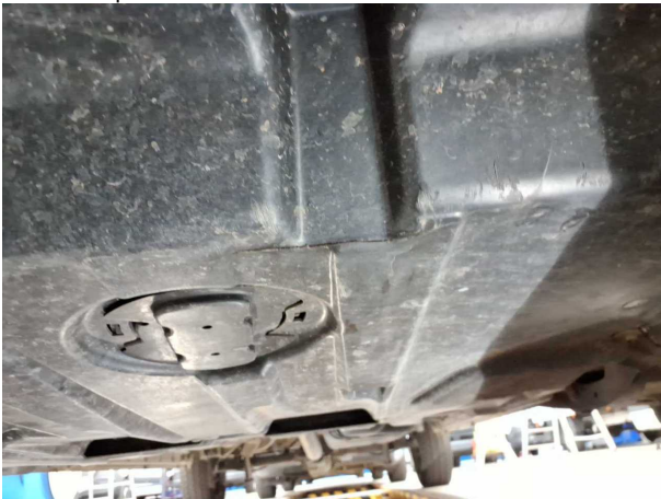
Beschädigung #5: Motor: Motorverkleidung unten - gebrochen / gerissen - erneuern
