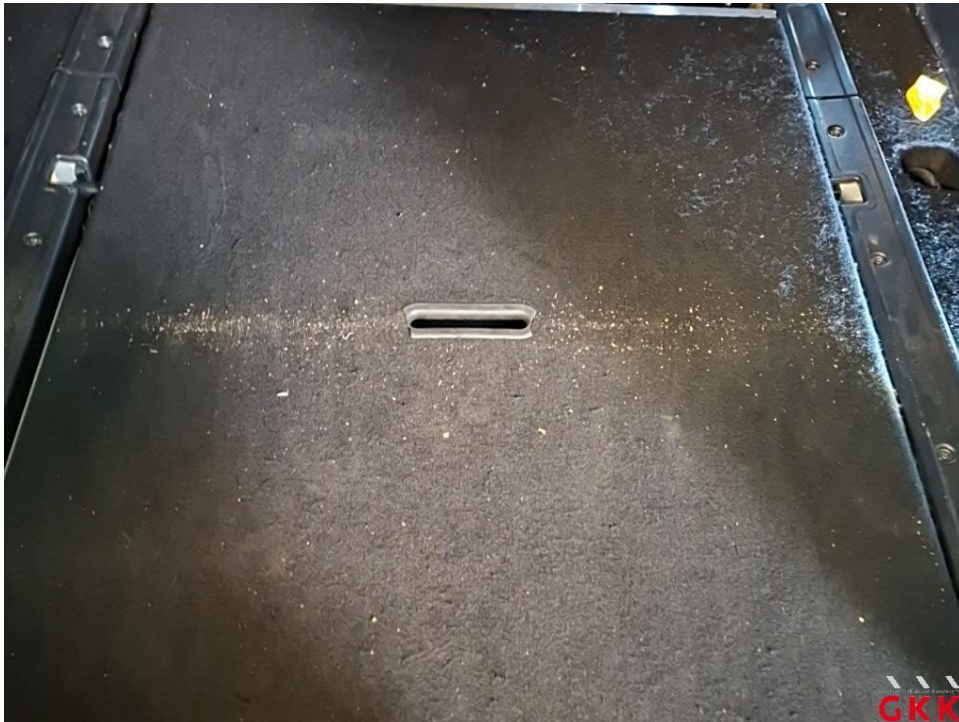
Bild 17 Blende Rampe mitte, beschädigt, ersetzen
