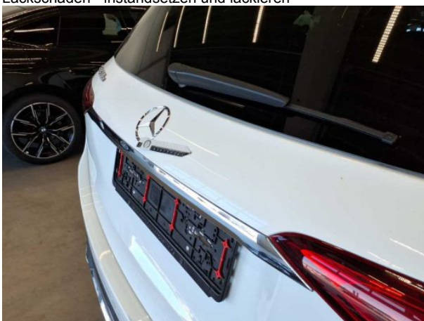
Beschädigung #12: Heckklappe/-tür: Heckklappe - Delle / Lackschaden - instandsetzen und lackieren
