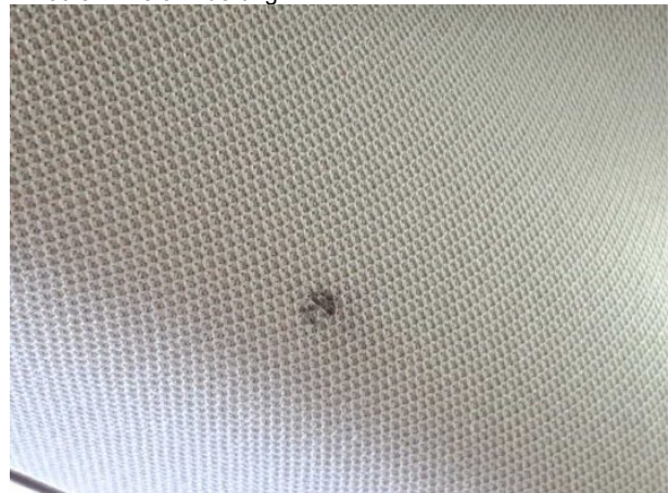
Beschädigung #3: Verkleidungen/Abdeckungen: Dachhimm... Löcher - Smart Repair
