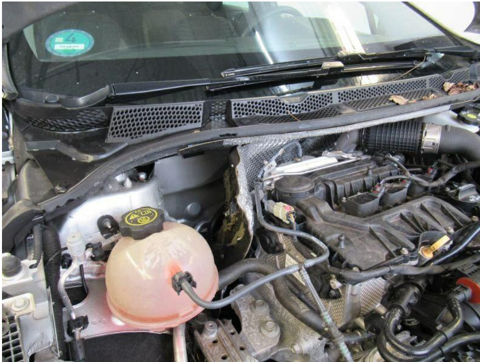
Bild 23 : Motorraum: Dämm/Schallschutz beschädigt (Stirnwand/ Wasserkasten) Nager.
