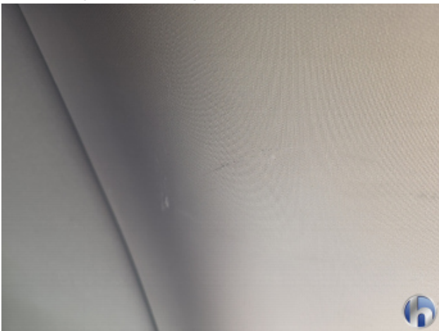
8. Dachhimmel Gebrauchsspuren - Ohne Reparatur
