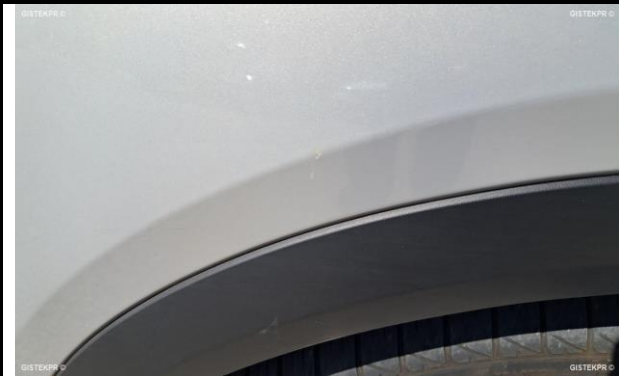
Foto daños externos 1
