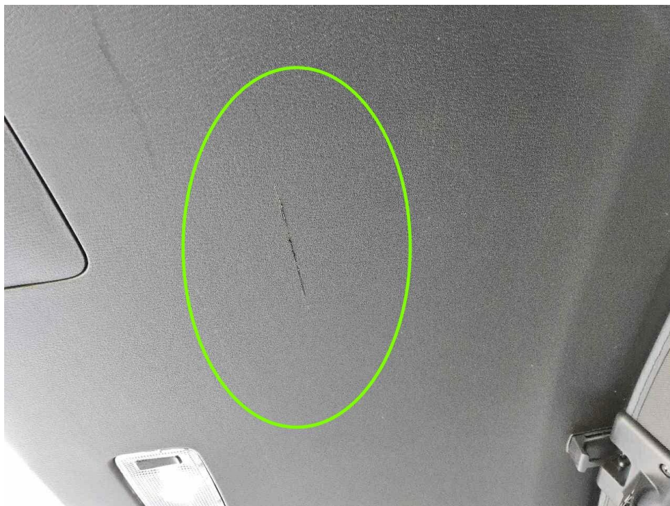
Bild 17 : Heckklappen innenverkleidung eingerissen
