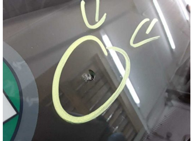
Beschädigung #9: Verglasung: Frontscheibe (Rissbildung) - Steinschlag - erneuern
