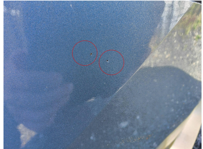
Bild 2: Außen, Stoßfänger vorne - Lackierung, Steinschlag, lackieren
