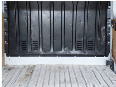
Panneau séparation cabine / - / Enfoncement
