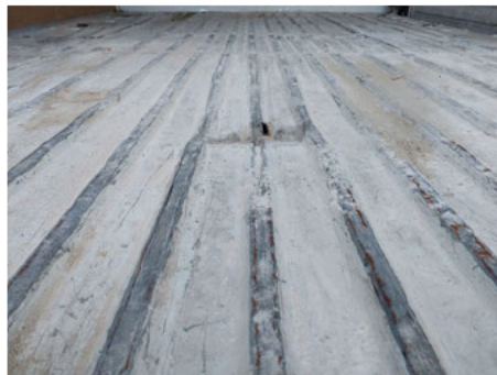
Plancher AR / Arrière / Enfoncement
