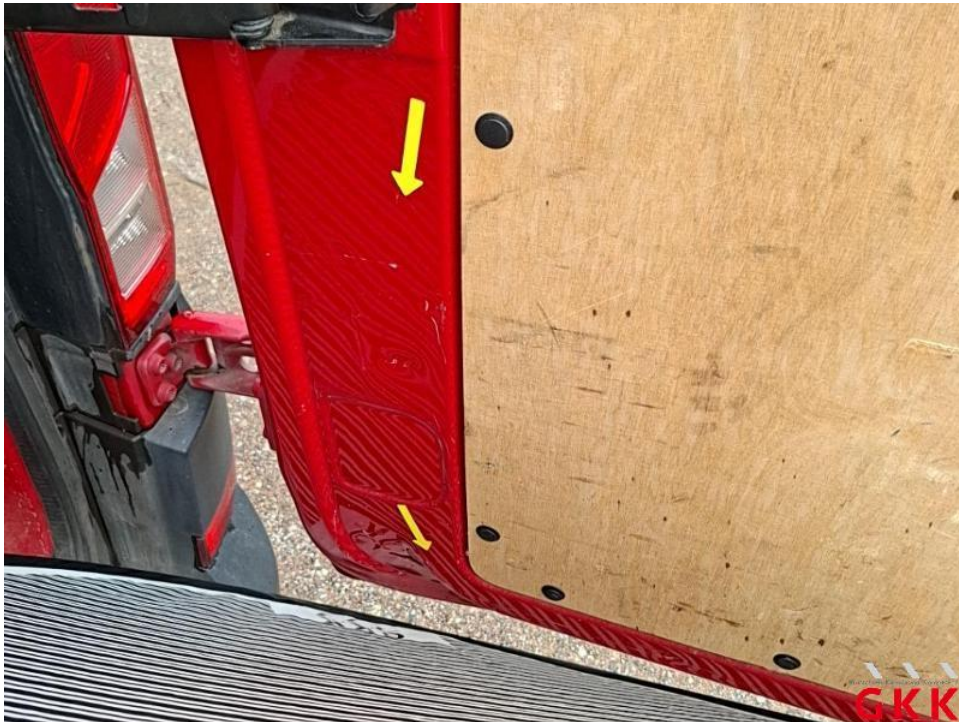
Bild 28. Hecktür rechts, innen, beschädigt, instand setzen - lackieren
