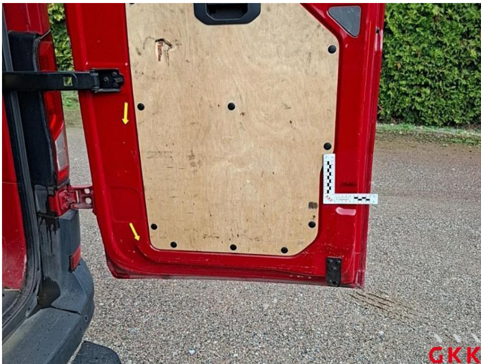
Bild 26. Hecktür rechts, innen, beschädigt, instand setzen - lackieren
