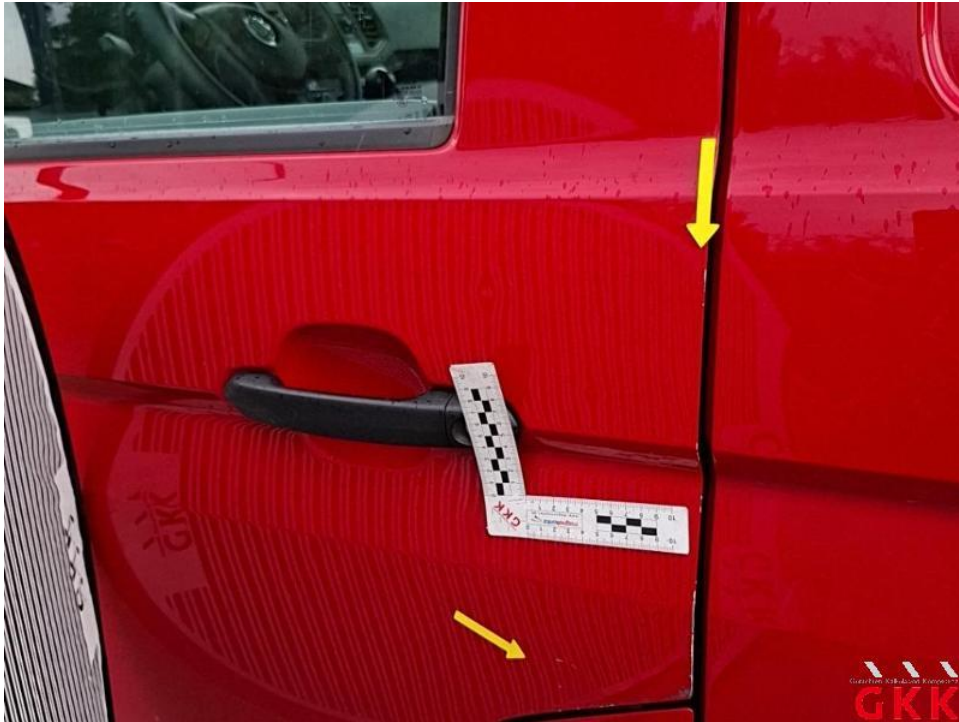
Bild 37. Tür vorne links, beschädigt, instand setzen - lackieren
