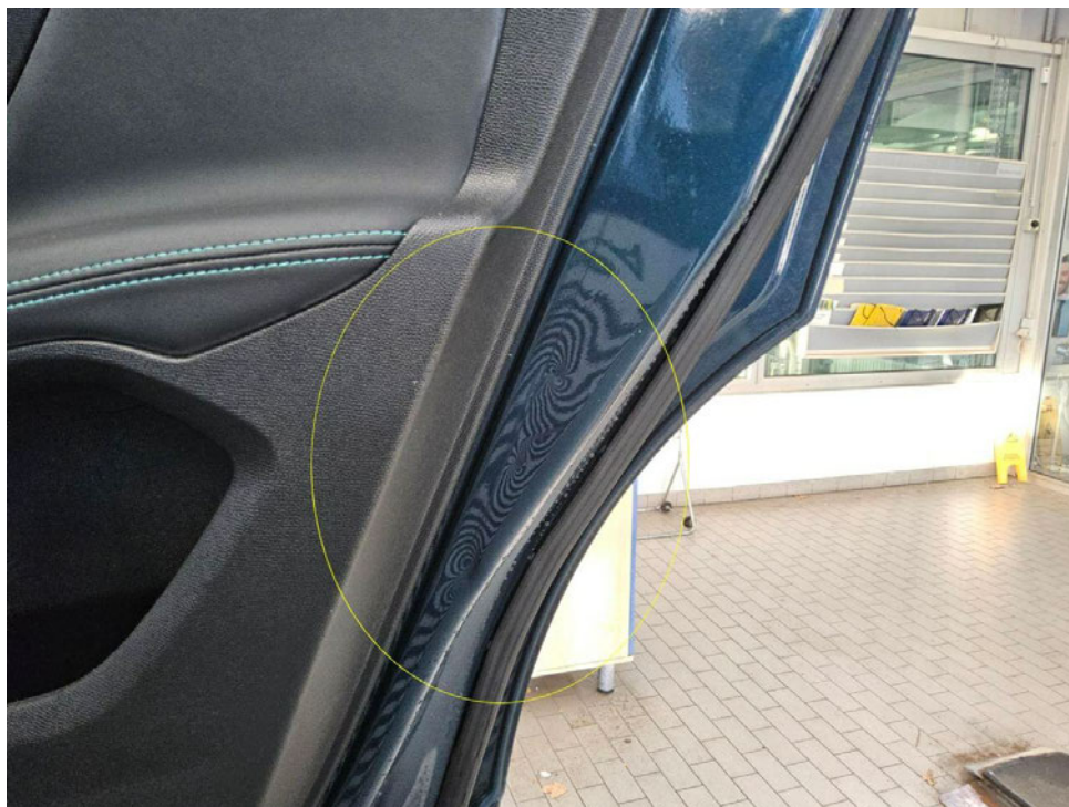
Bild 9 : Tür hinten rechts, eingedellt, instandsetzen und lackieren mit Lackaufbau
