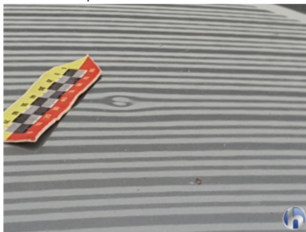
5. Dach 1 Delle - Sanft Instandsetzen
