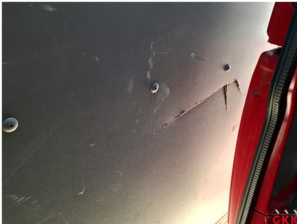
Bild 32. Schiebetür rechts, Innenverkleidung, beschädigt, ersetzen
