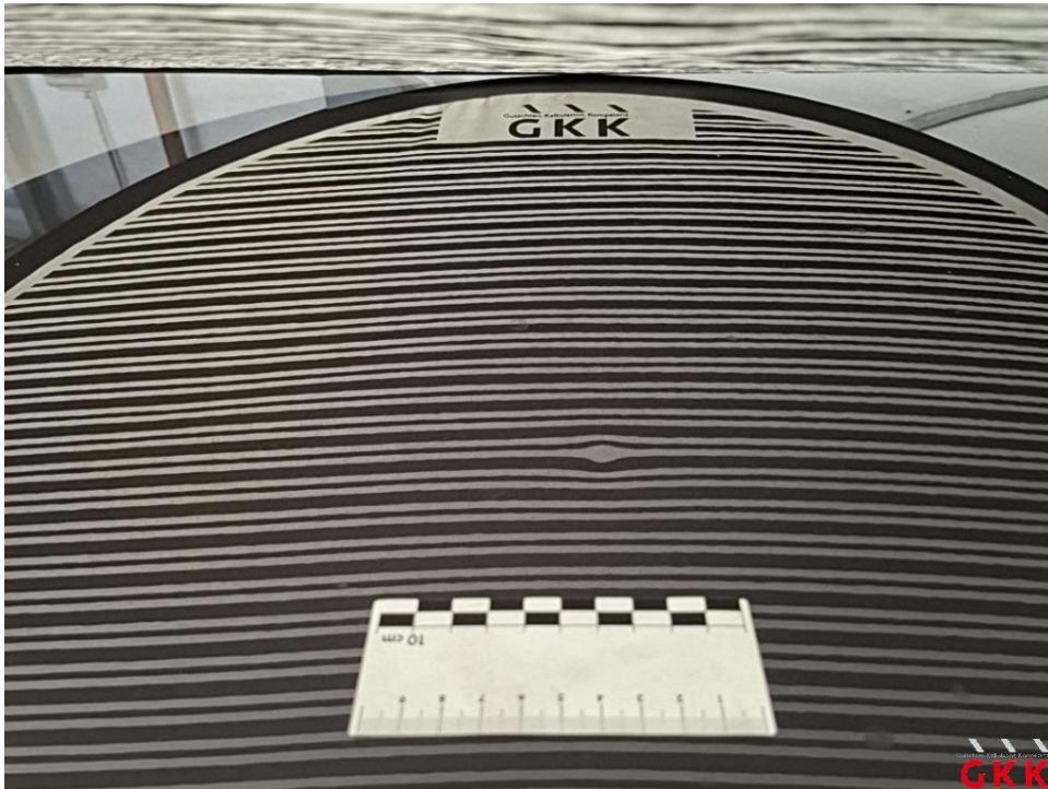
Bild 26 Dach, beschädigt, kalt drücken
