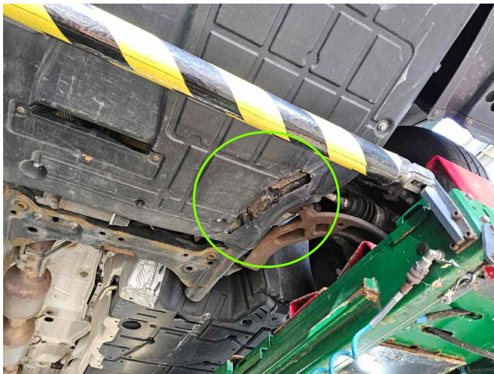
Bild 36 : Unterfahrschutz vorne gebrochen
