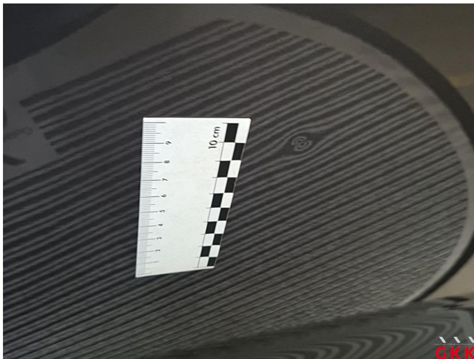
Bild 37 Tür vorne rechts, beschädigt, instand setzen - lackieren
