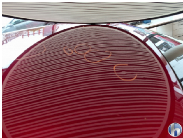
6. Dach Hagelschaden - Sanft Instandsetzen
