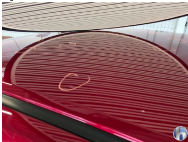
6. Dach Hagelschaden - Sanft Instandsetzen
