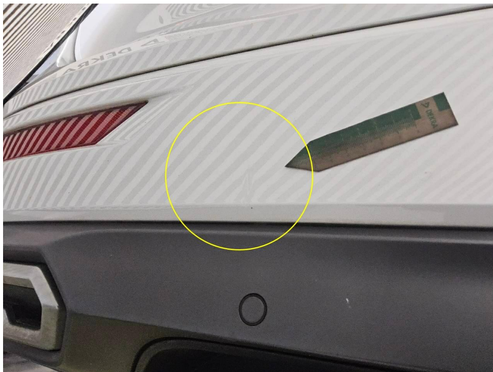
Bild 14 : Stoßfänger hinten, deformiert, instandsetzen und lackieren mit Lackaufbau
