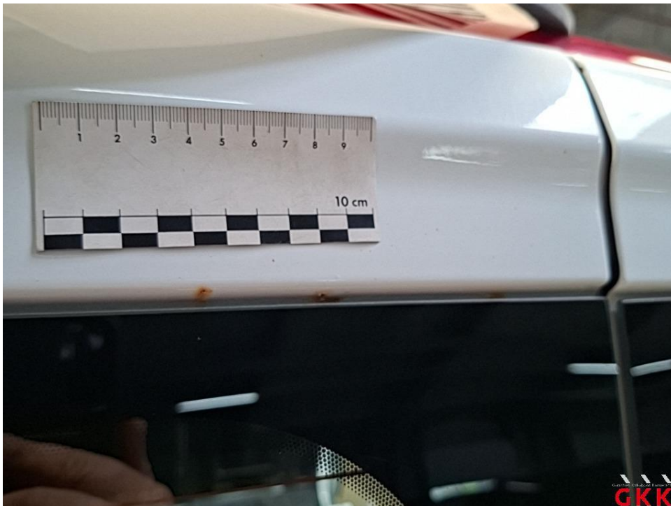
Bild 46 Hecktür links, korrodiert, lackieren
