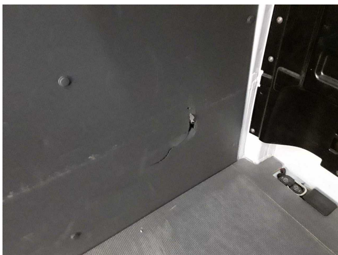
Damage 4: Interior: Interior (Laderaumverkleidungen) - Broken / torn - Replace
