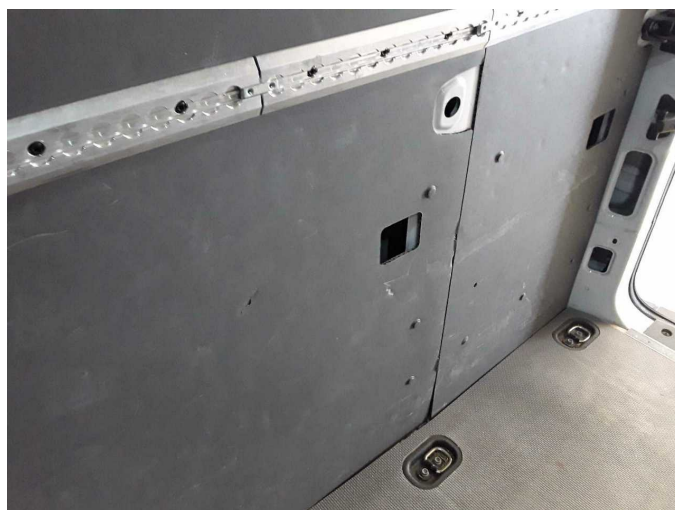
Damage 4: Interior: Interior (Laderaumverkleidungen) - Broken / torn - Replace
