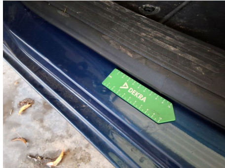
Door sill / Front Left / Dent
