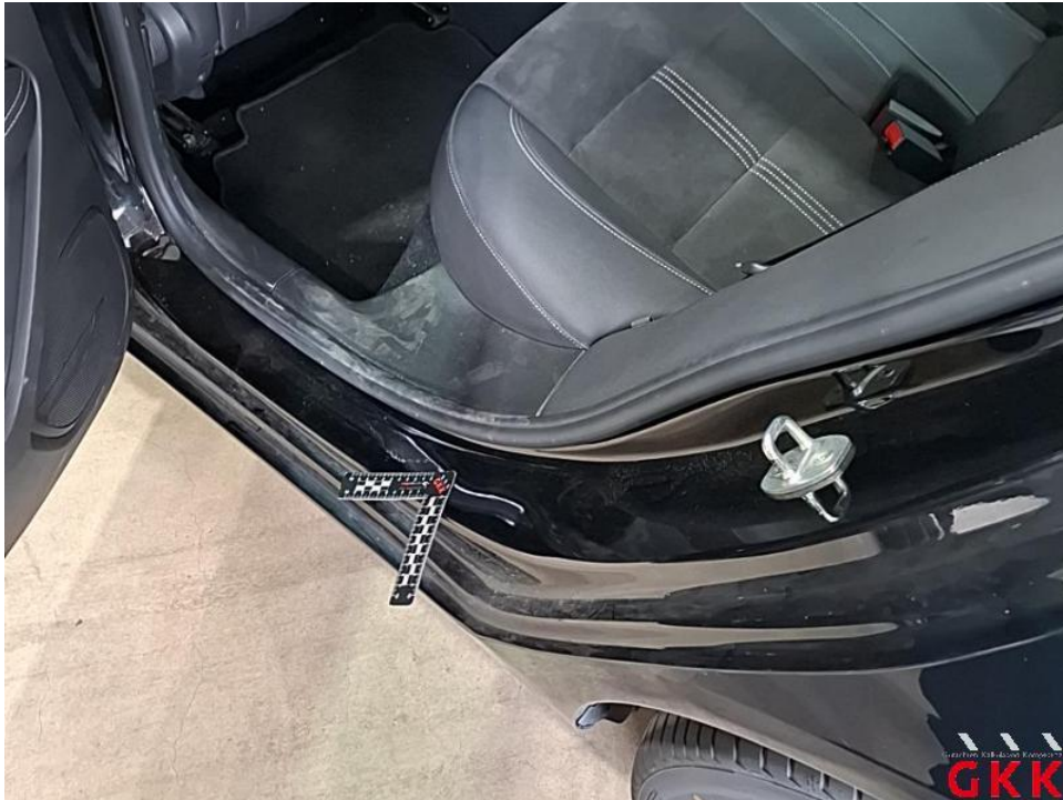
Bild 41. Tür hinten links, Einstieg, beschädigt, instand setzen - lackieren
