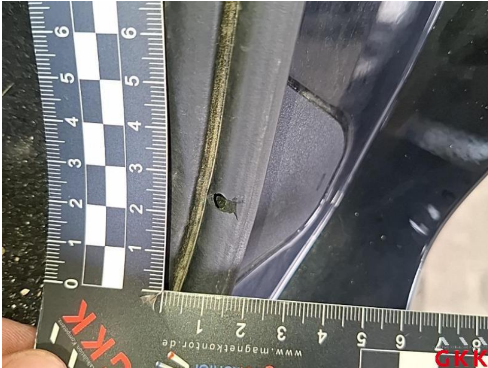
Bild 55. Heckklappe, Dichtung, beschädigt, ersetzen
