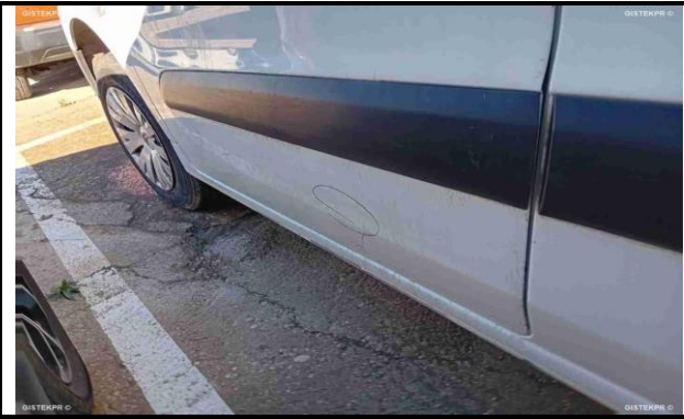
Foto daños externos 1
