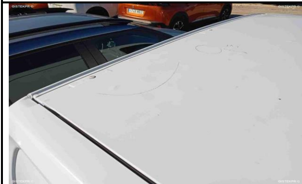
Foto daños externos 1
