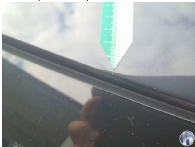
9. Dach Gebrauchsspuren - Ohne Reparatur
