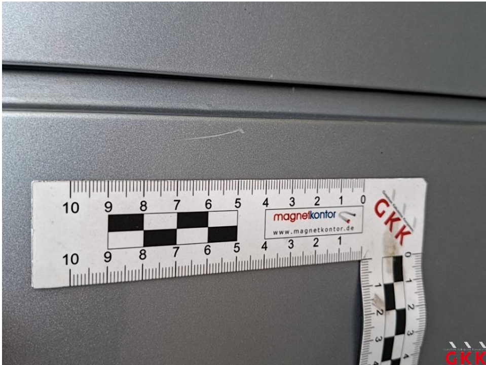
Bild 22. Schiebetür rechts, verkratzt, lackieren
