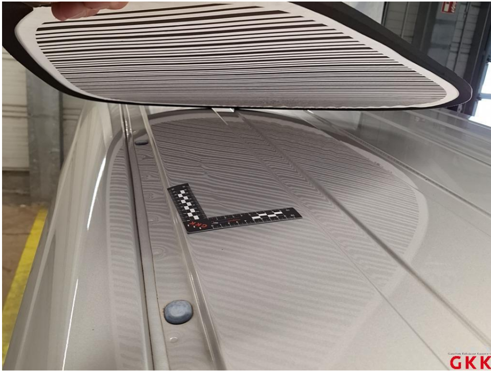
Bild 15 Dach, beschädigt, instand setzen - lackieren
