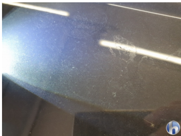
4. Dach Lackabplatzer - Lackieren
