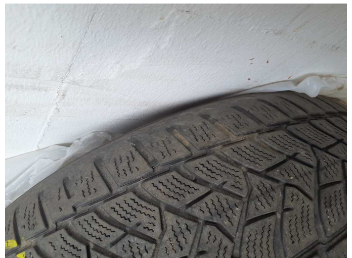
Damage 2: 2nd wheel set: 1 tyre (Und platt // gehört nicht zur Ausstattung) - Worn
