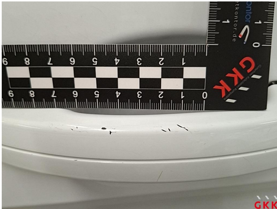
Bild 34 Schiebetür links, Griff, verkratzt, lackieren ohne LV
