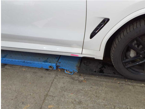
Beschädigung #1: Schweller rechts: Verkleidung (Blende) - fehlt - erneuern
