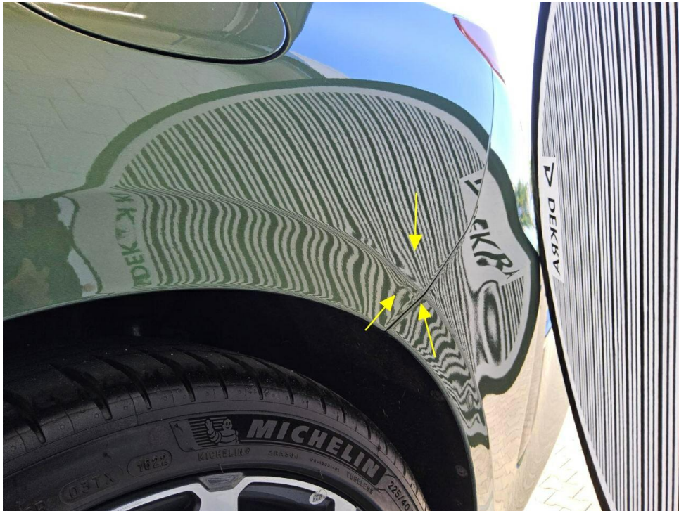
Bild 13 : Seitenteil hinten links, deformiert, instandsetzen und lackieren mit Lackaufbau
