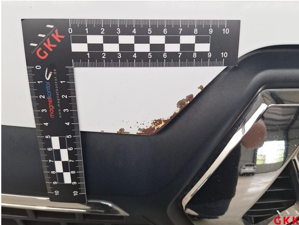
Bild 19. Motorhaube, beschädigt, instand setzen - lackieren
