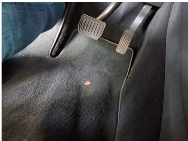
Beschädigung #1: Verkleidungen/Abdeckungen: Fußmatten - beschädigt - erneuern
