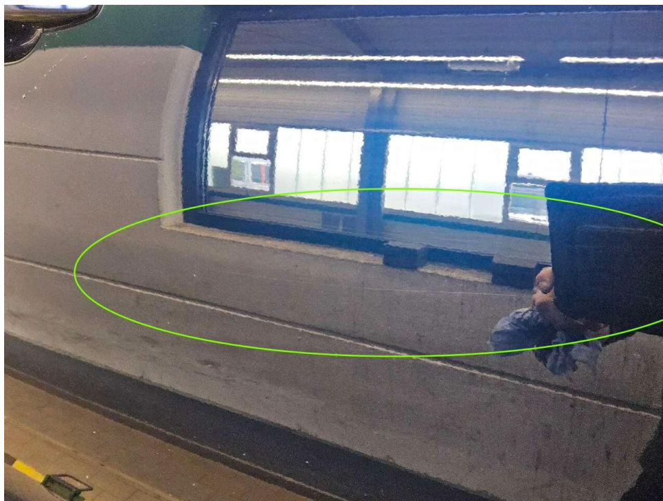
Bild 19 : Oberflächenkratzer an mehreren Bauteilen
