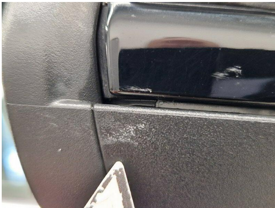
Bild 31 : ASP rechts Rahmen verschrammt
