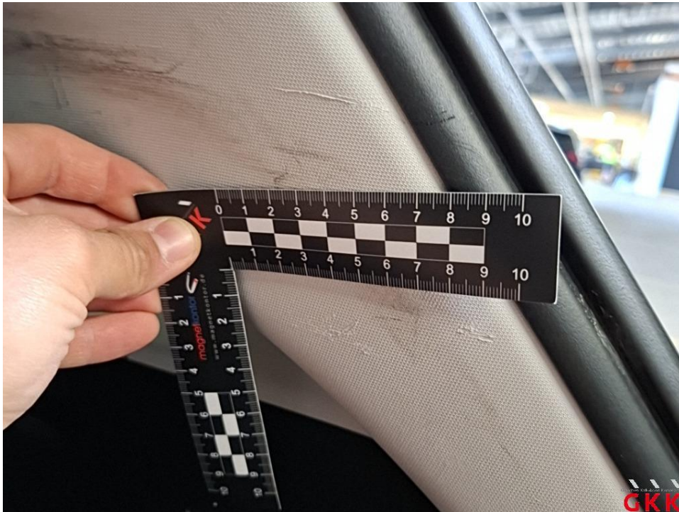
Bild 33 D- Säule rechts, Innenverkleidung, verkratzt, ersetzen
