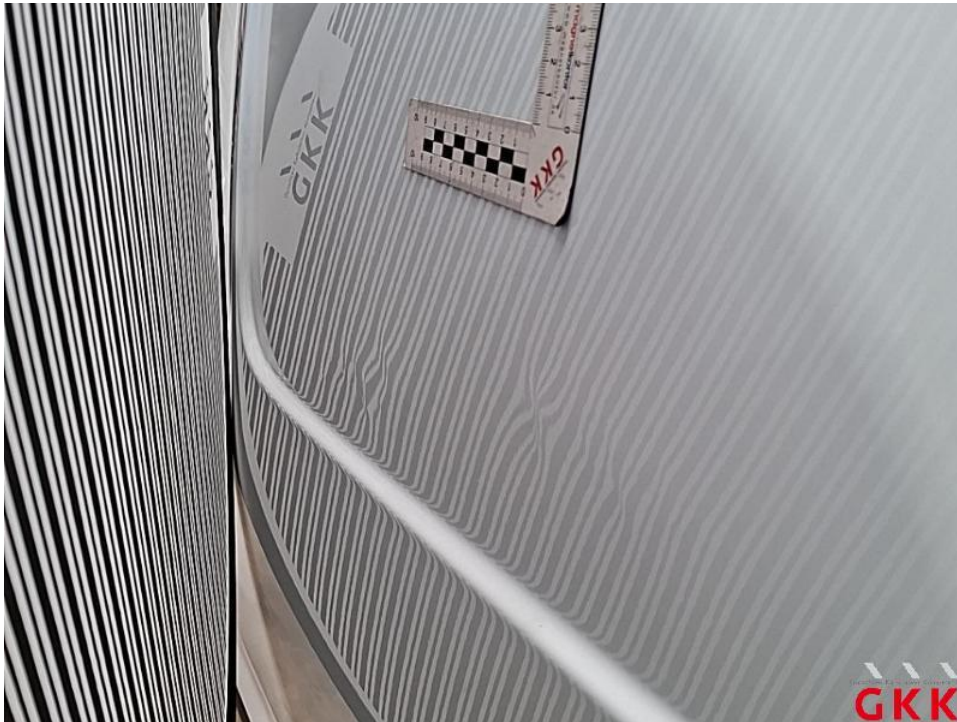
Bild 32. Seitenwand links, beschädigt, instand setzen - lackieren
