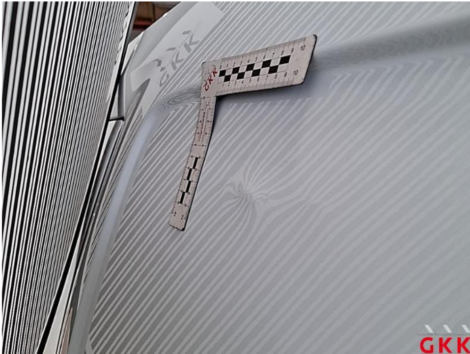
Bild 33. Seitenwand links, beschädigt, instand setzen - lackieren
