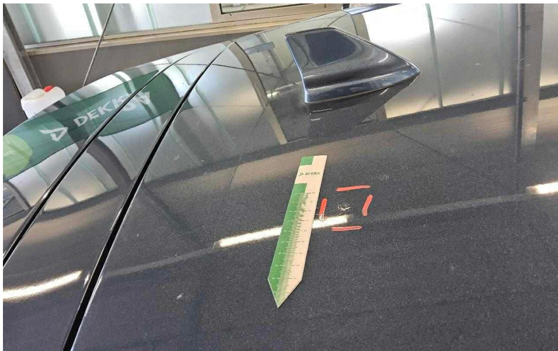
Bild 13 : Dach Lackierung, Umweltschaden, lackieren mit Lackaufbau
