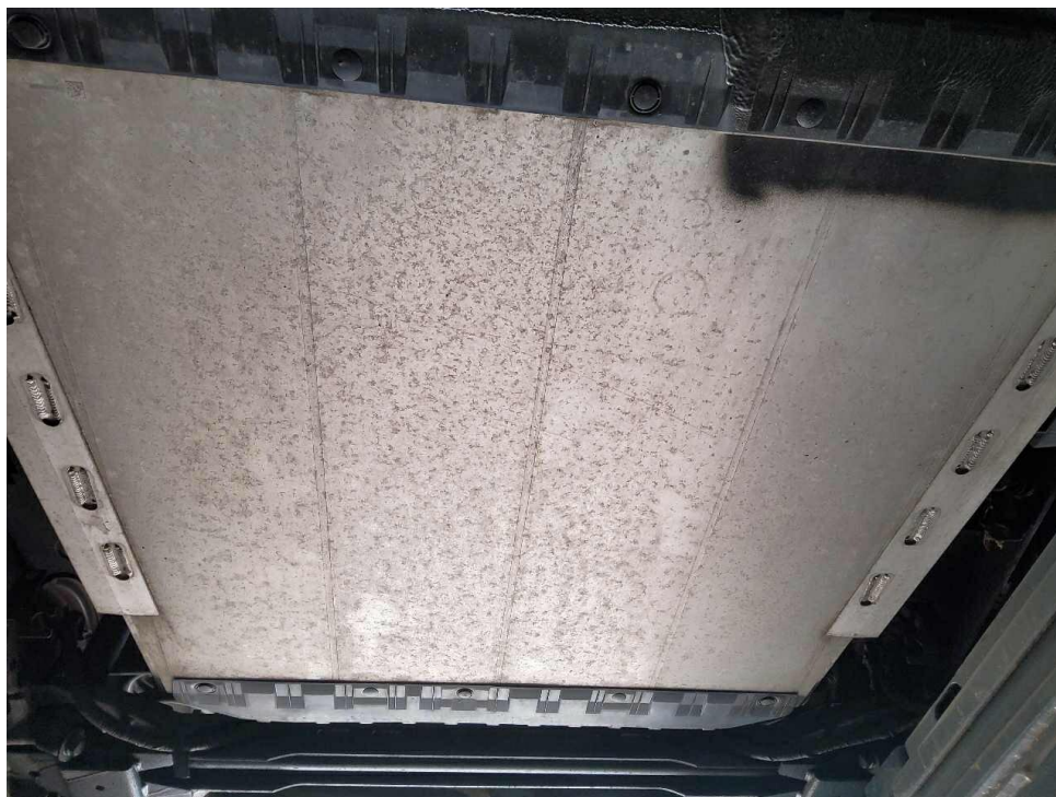
Bild 11 : HV-Batterie in Ordnung
