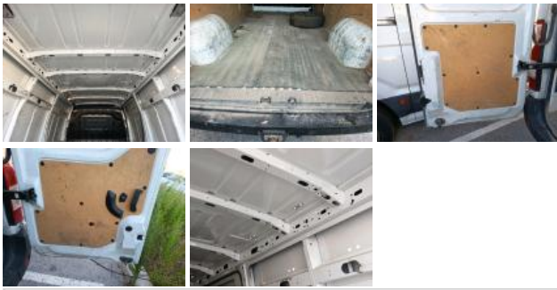
Door panel RR, Broken, Replace
