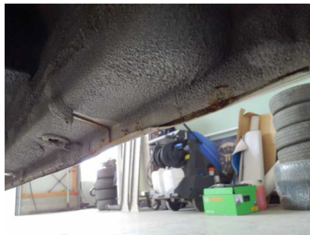
Beschädigung #7: Schweller rechts: Schweller - verformt - instandsetzen
