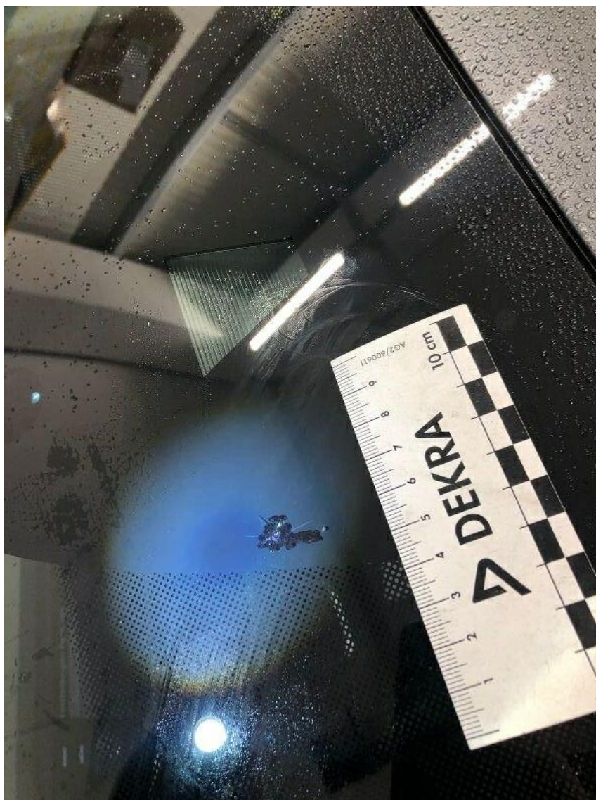
Bild 17 : Frontscheib Steinschlag / Riss
