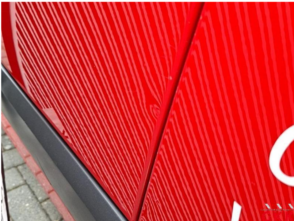
Bild 30. Schiebetür rechts, beschädigt, instand setzen - lackieren
