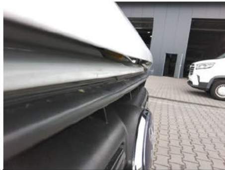
Stoßfängergrill / Vorne / Gebrochen
