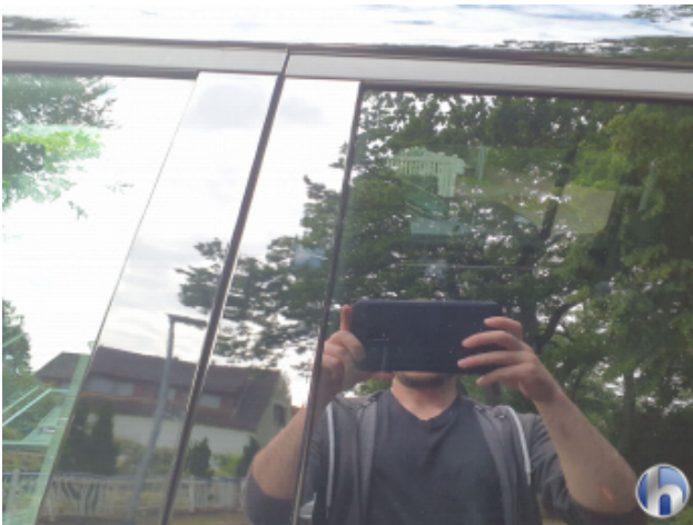
8. B-Säule Mitte - Links Beschädigt - Erneuern
