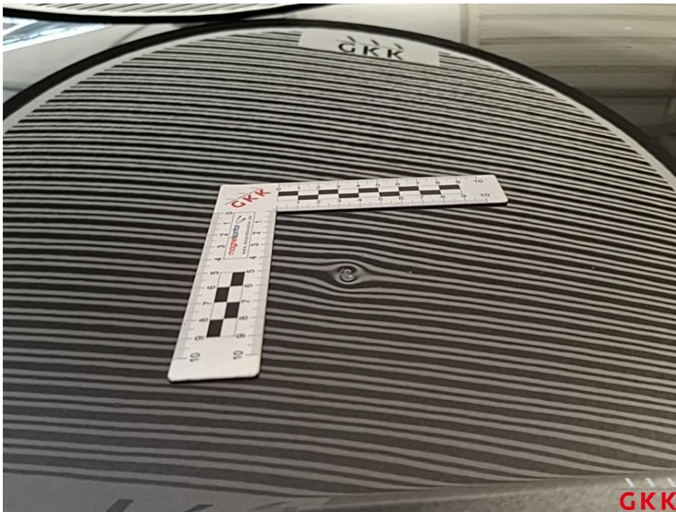
Bild 22 Dach, beschädigt, instand setzen - lackieren
