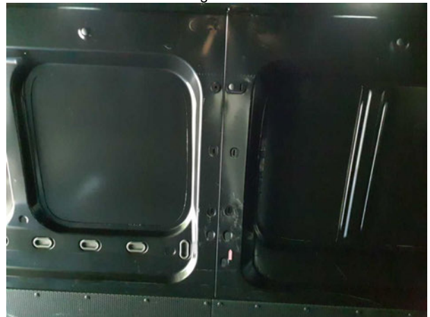
Beschädigung #9: Interieur: Laderaumunterteilung - Delle / Lackschaden - Wertminderung
